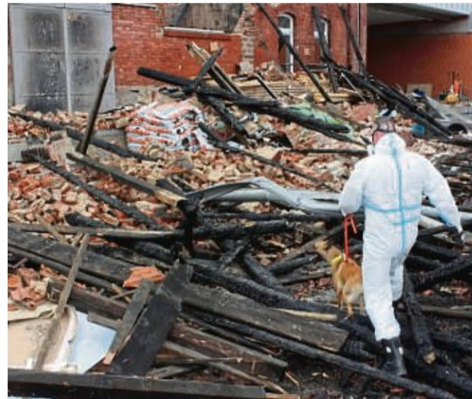
Spurensuche: Bei den Ermittlungen zur Ursache des Brandes auf dem Gelände des BHG Baumstoffmarktes setzte die Polizei Brandmittelspürhunde ein.
